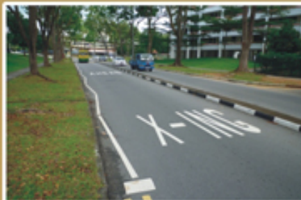
Road Marking 前方行人过道
